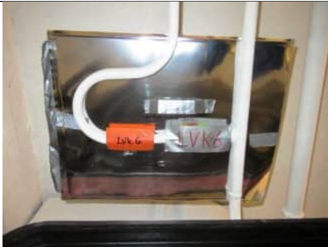
Kellarikerros, VSS-tilat; Lvk-runkolinja tilan katon rajassa 17/1,0 mm
