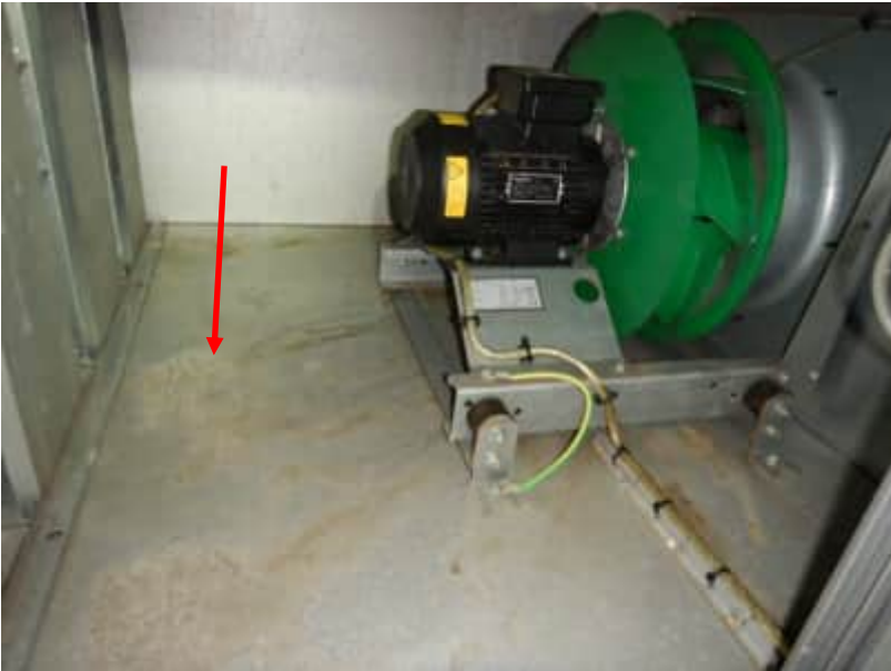
Kuva 31. Tuloilmapuhallinkammio on likainen.
