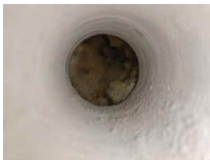
Rakennavaus JS5, rakenne vastaa suunnitelmia.
