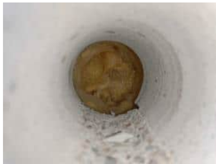
Rakennavaus RA.5-US, rakenne vastaa suunnitelmia
