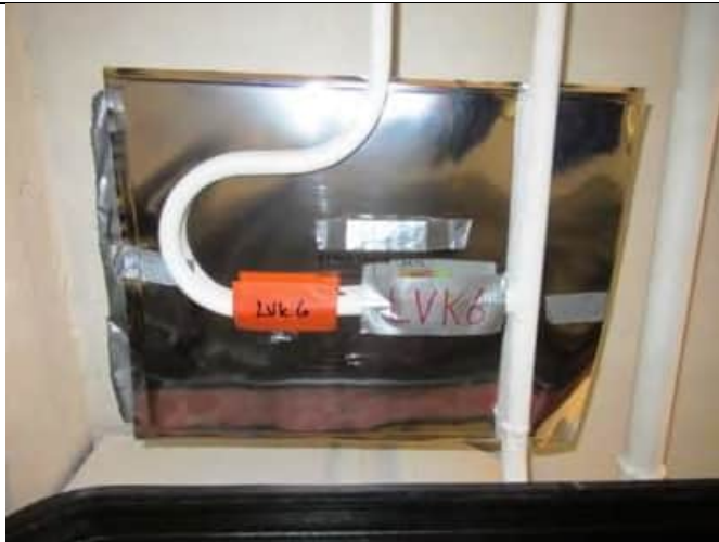
Kellarikerros, VSS-tilat; Lv-runkolinja tilan katon rajassa 22/1,2 mm
