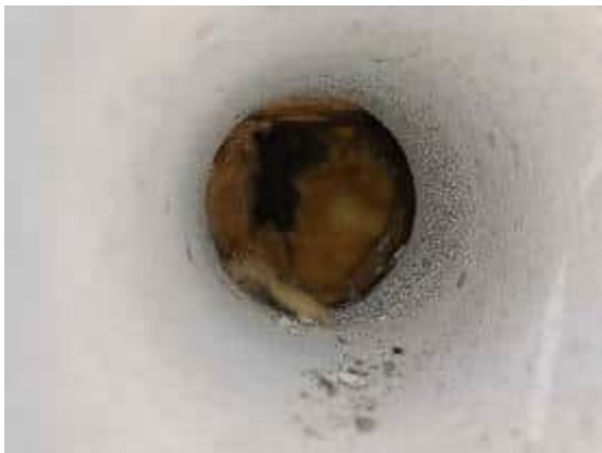
Rakennavaus RA.2-US ja RA.3-SOK, rakenne vastaa suunnitelmia
