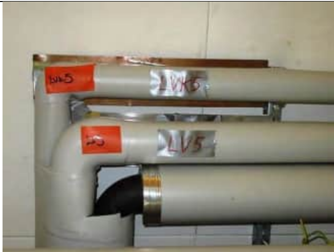
1. kerros, Käytävätila 2.26; Lvk-runkolinja tilan katon rajassa 22/1,0 mm
