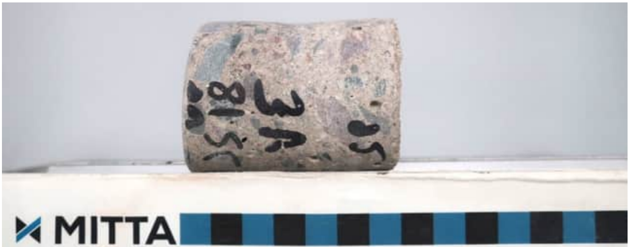
JS18, ulkopinta vasemalla.
