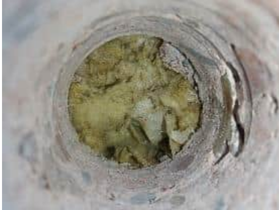
Rakennaus JS24, rakenne vastaa suunnitelmia
