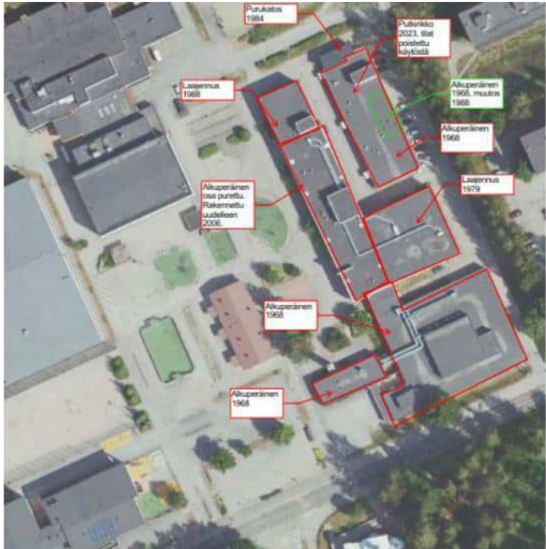
Kuva 2.2. Ylä-Kartanon rakennusvaiheet (Tilaajan toimittama aineisto). Teknisen työn rakennuksessa on ollut vuonna 2023 putkirikko, jonka vuoksi tilat on poistettu käytöstä.
