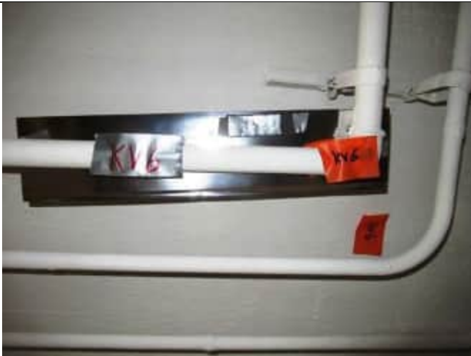
Kellarikerros, VSS-tilat; Kv-runkohaara tilan katon rajassa 33,5/3,25 mm
