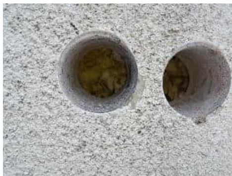
Rakennaus JS4/15, rakenne vastaa suunnitelmia.
