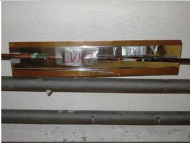
Kellarikerros, VSS-tilan käytävä; Lvk-runkohaara tilan katon rajassa 12/1,0 mm
