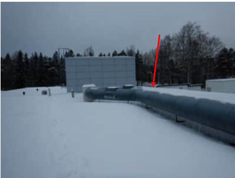
Kuva 42. Kanavat on asennettu osittain vesikatolle näkyville
